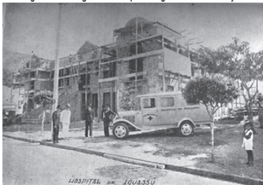
Figura 02 – Fotografia do Hospital de Iguassú em construção
